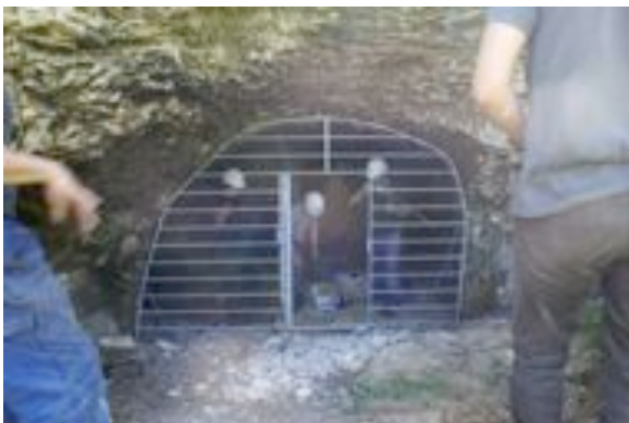
Pose d'une grille anti-intrusion sur mesure
