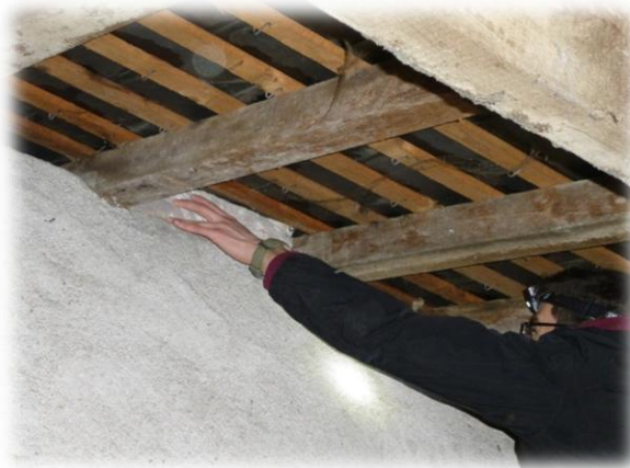
Mise en place de caches-moineaux en laine de chanvre.
