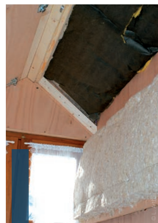
Construction d'un caisson isolé
