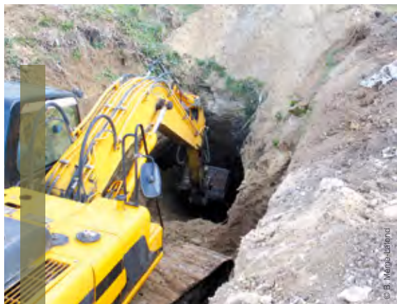
Réouverture d'un site dont l'entrée avait été remblayée
