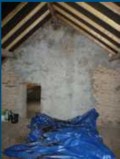
Aménagement provisoire réalisé en juillet 2012
