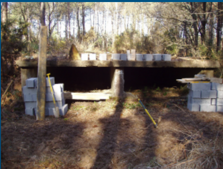
Avant travaux (photo : Mickaël Ricordel)
