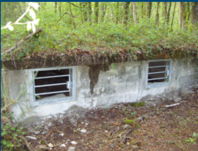
Après travaux (photo : Mickaël Ricordel)
