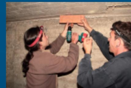
Pose de briques plâtrières dans le transformateur.
