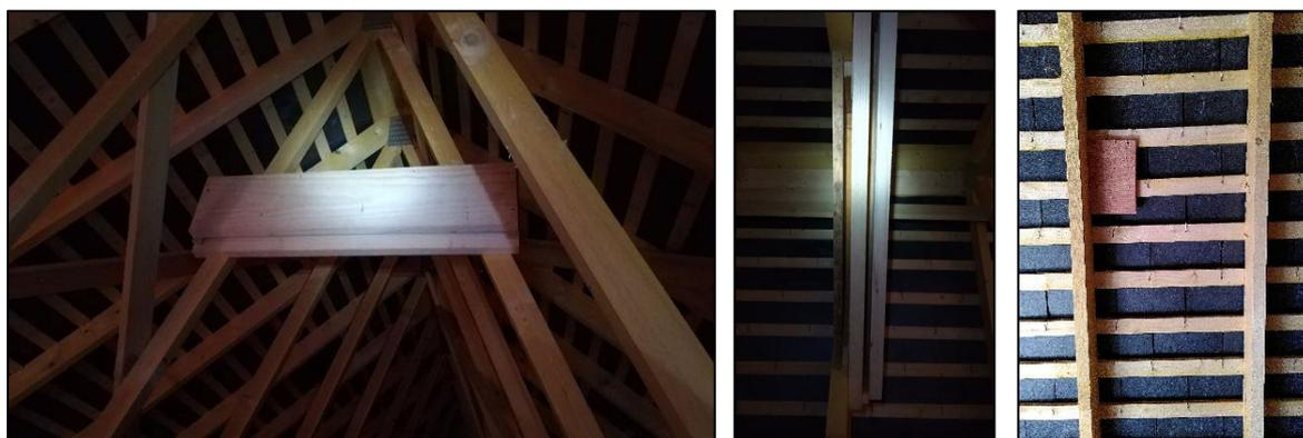
Gîtes et micro-gîtes pour les chauves-souris installés dans les combles du bâtiment en construction. Photos 1 et 2 (de gauche à droite) : gîte posé en hauteur vu de côté et de dessous. Photo 3 : micro-gîte installé sous les ardoises du toit, de manière à chauffer en présence de soleil, ce qui pourra favoriser les colonies estivales pour la mise-bas et le développement des jeunes.
