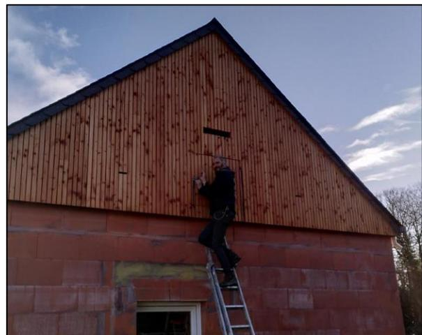
Des gîtes et micro-gîtes ont donc été conçus et posés dans les combles de l'habitation en construction. Ceux-ci consistent en des planches de bois assemblées entre elles et présentent des petites fentes pour permettre aux chauves-souris de s'y faufiler. Ainsi, quatre gîtes et huit micro-gîtes ont été installés.
