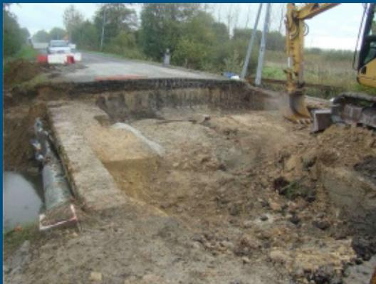
Décaissement du substrat au-dessus des dalots
